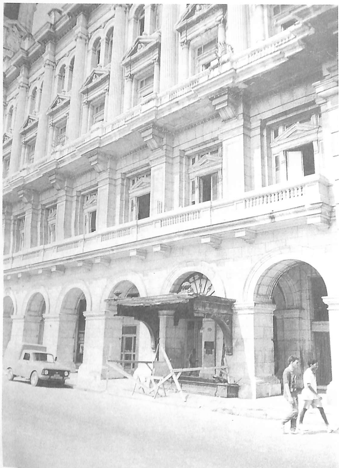
Fachada lateral del Antigua Centro Asturiano de La Habana. Entrada de acceso a la Taberna (estado actual)
